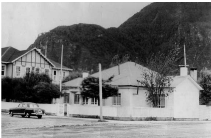
Edificio de la Intendencia y la casa del intendente.
