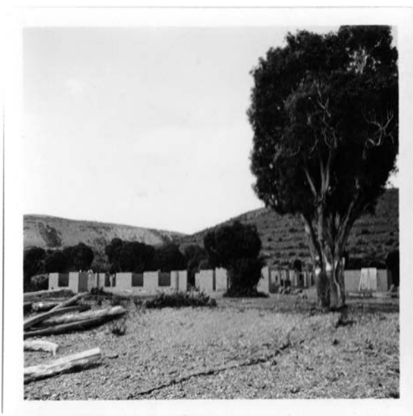
Construcción de la casa en San José, el constructor fue el tío Toni Llompart.
